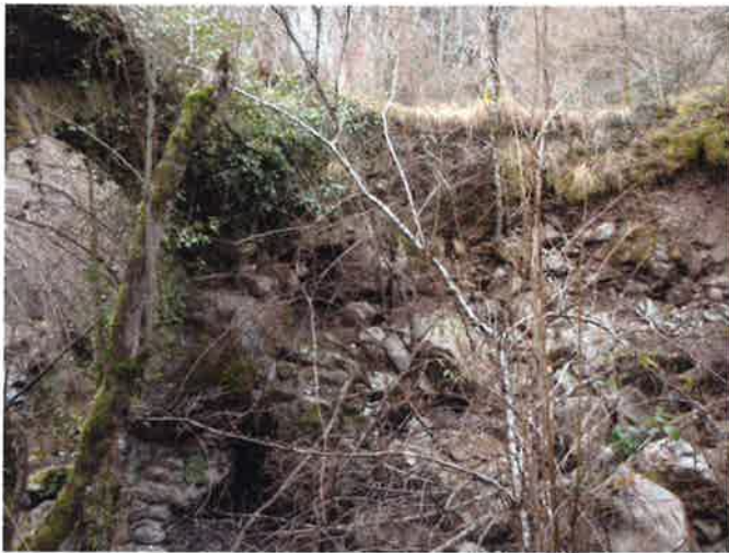
Glissement de terrain sur la partie amont – Source © CAUE 64
