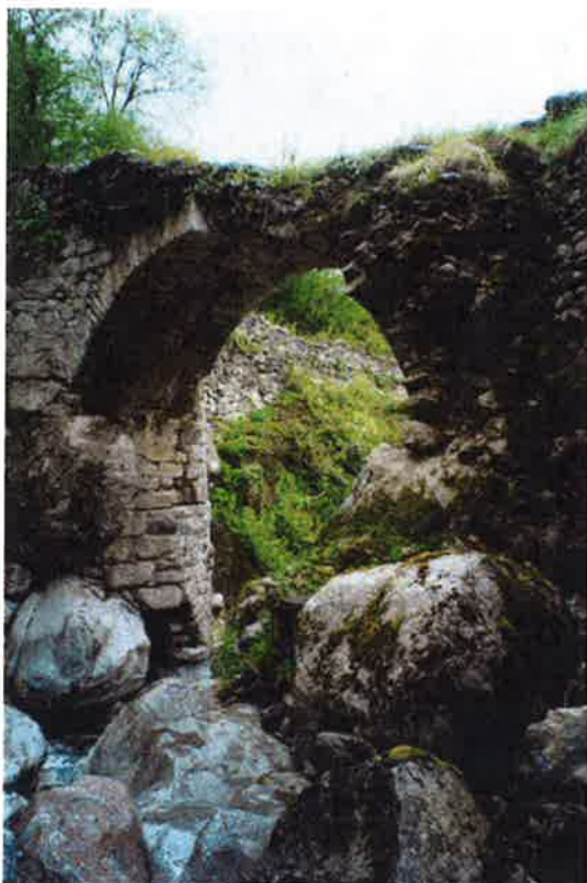
Vieux pont de Belhonce en 1999 - © Mairie de Borce
